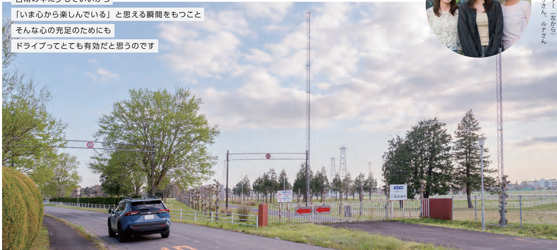
「KDDI八俣送信所(古河市東山田4428)」敷地を縦断する道路から、巨大な鉄塔に張り巡らされたカーテンアンテナやLPアンテナなどを見ることができます。
